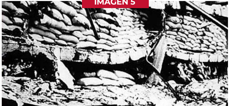
EDIFICIO DE 4 NIVELES EXCEDIDO ENORMEMENTE EN CARGAS
