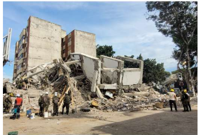
Foto 5. Estado del edificio en agosto 14 de 2026. Caso 1 (Foto: Zulma S. Pardo V.)
