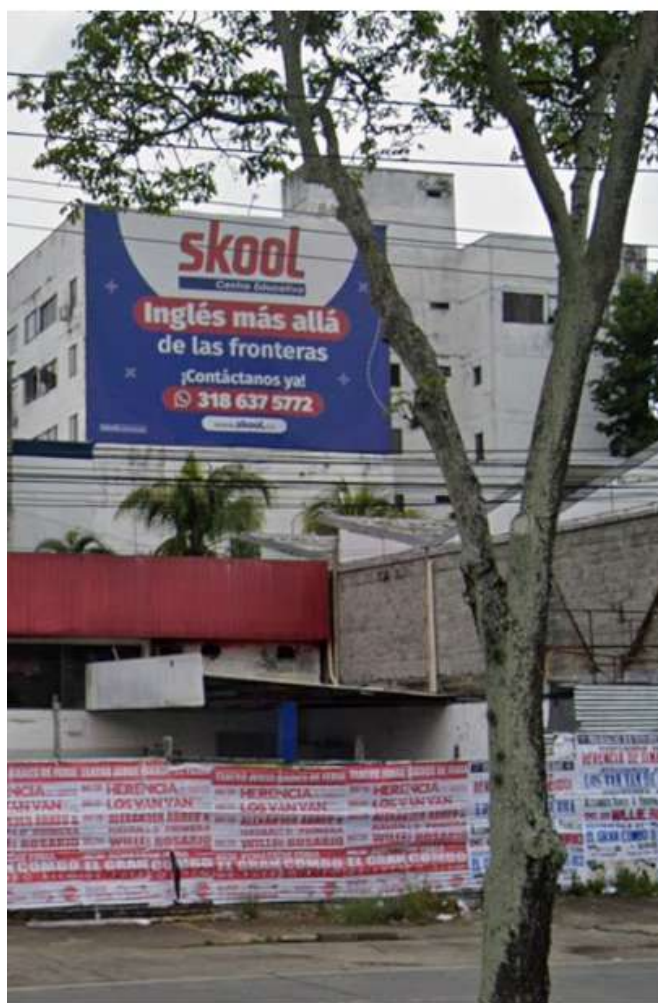
Foto 3. Vista occidental edificios Caso 1 (Ref: Google maps)
