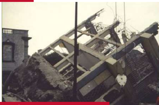
FALLA POR CIMENTACIÓN DEFICIENTE
