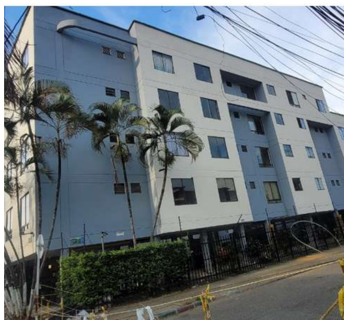
Foto 10. Edificio Caso 3 (Foto: Zulma S. Pardo V.)
