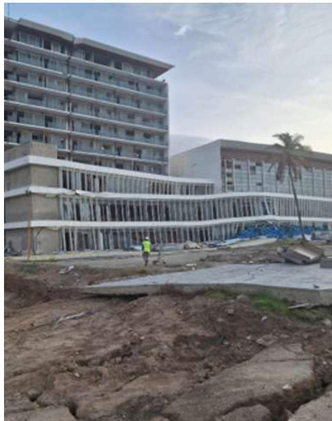
Figura 4. Licuación y deformación del terreno. (foto Marianela Lafuente)
