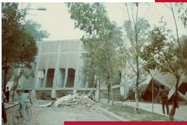
FALLA POR CIMENTACIÓN DEFICIENTE
