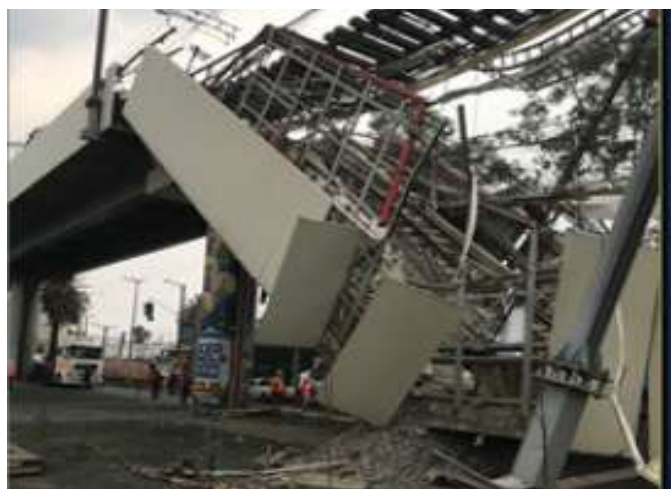
DESPLOME DEL METRO ELEVADO CDMX, 3 DE MAYO 2021, 22:22 HS
