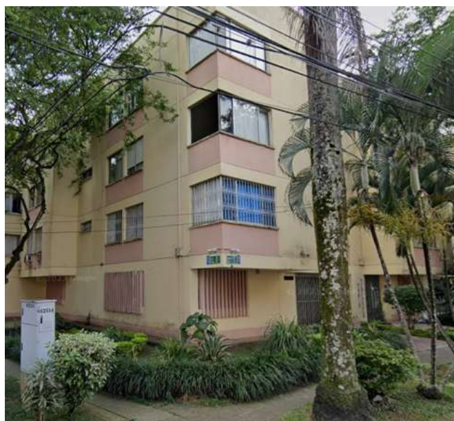
Foto 14. Vista Oriente edificio Caso 4 (Ref: Google maps)
