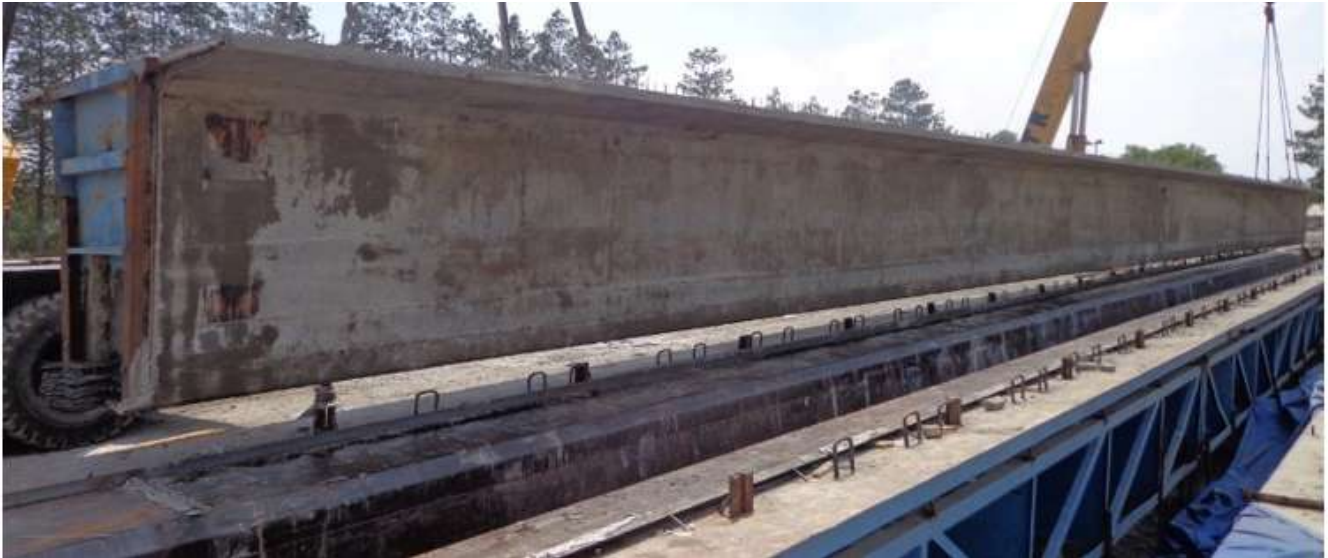
Figura 2. Molde (cimbra metálica) para trabe cajón pretensada.
