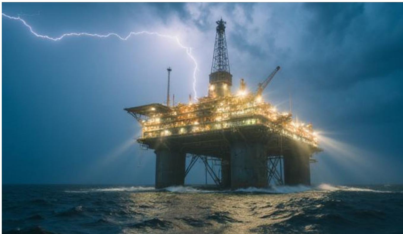
Imágenes: Ejemplos de algunas estructuras que han resistido el impacto de grandes sismos y huracanes y su comportamiento estructural ha sido excepcional.
