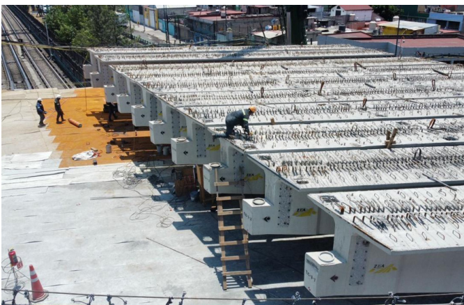
Figura 4. Montaje de trabes TA.
