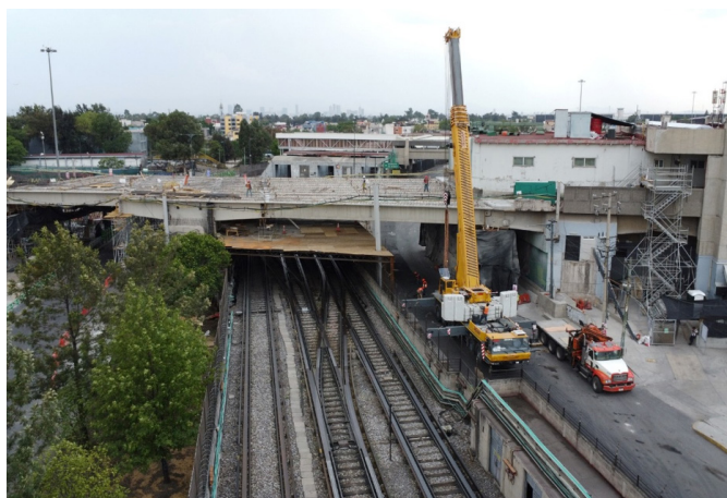
Figura 2. Trabes TC apoyadas sobre las trabes TA.
