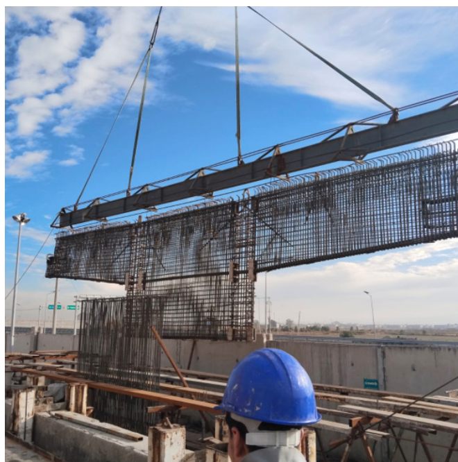
Figura 3. Colocación de armado para trabe TA.
