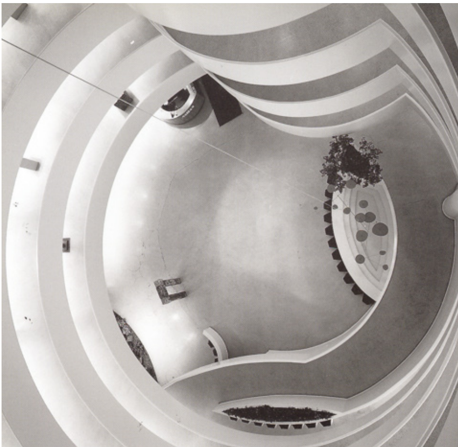
Atrio con rampas helicoidales en ménsula. Se puede apreciar la magnífica visual lograda gracias a la red de trazos armónicos. Se aprecia el juego de los barandales como bandas de cilindros escalonadas que delimitan el espacio sin obstruir la penetración de la luz y las visuales lo que hace lucir las formas arquitectónicas.
