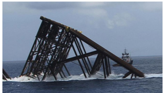
Maniobra de lanzamiento, flotación y posicionamiento vertical
